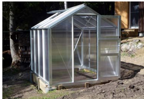
Das Ehepaar Heinz platzierte ihr MINI 40 auf einem Fundament aus mit Zement gefüllten Hohlblockpfeilern an den Ecken und imprägnierten Holzbrettern. (Foto: WAMA/Heinz)
